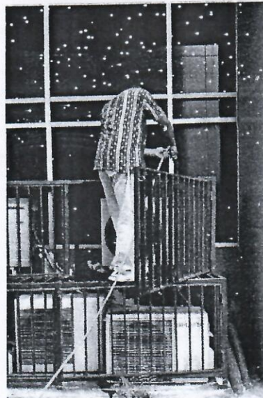
Perawatan AC UPS di BKN Pusat
