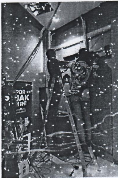
Perapihan instalasi jaringan lan di BKN Pusat
